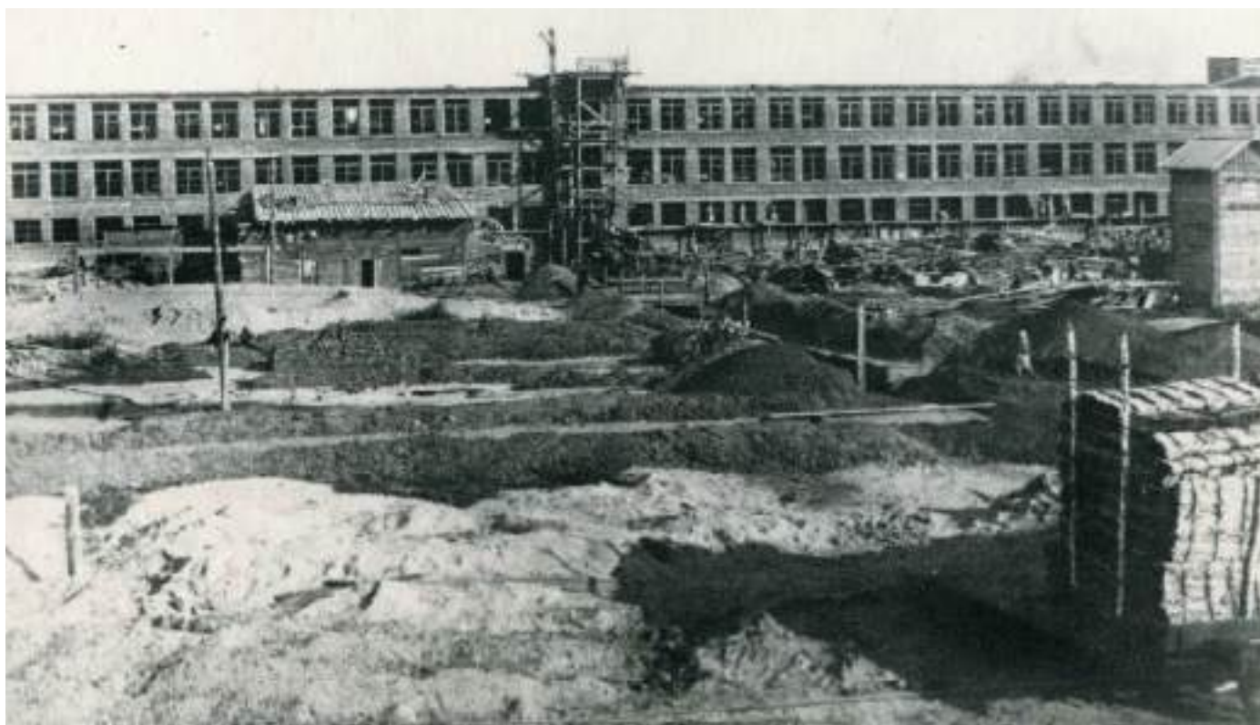
Строительство Меланжевого комбината. Барнаул, 1932 г.
